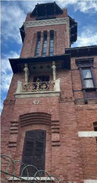
Şekil 6. Köşkün kuzeydoğu yönündeki pencereleri (Arıcı, 2024).
