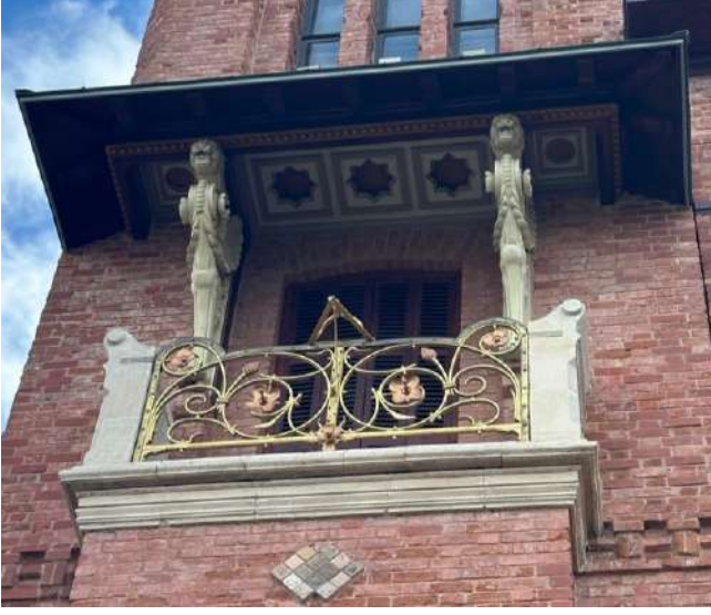
Şekil 7. Köşkün kuzeybatı yönündeki balkonu (Arıcı, 2024).
