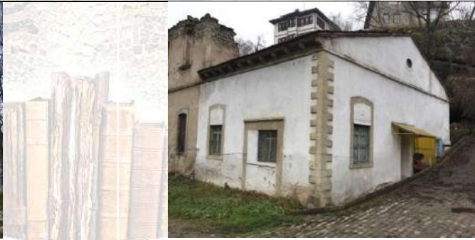
Şekil 8. Tabakhane Binası Sağ Cephe
