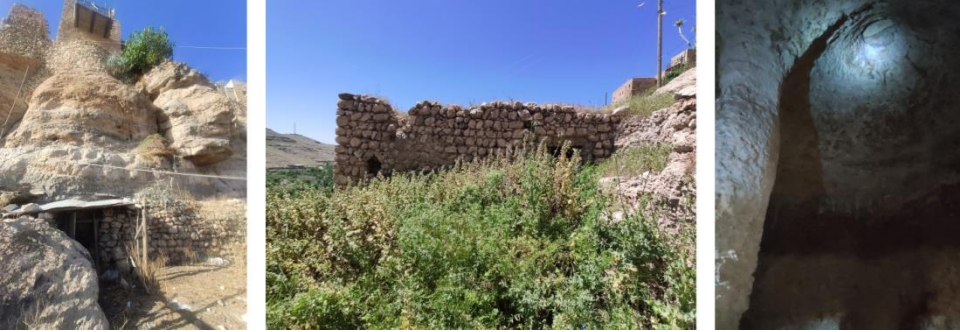
Şekil 7. Yerleşim alanında bulunan mağara yapıları.
