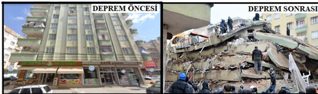
Şekil 3. Hasar tespit çalışmaları Şanlıurfa örneği
