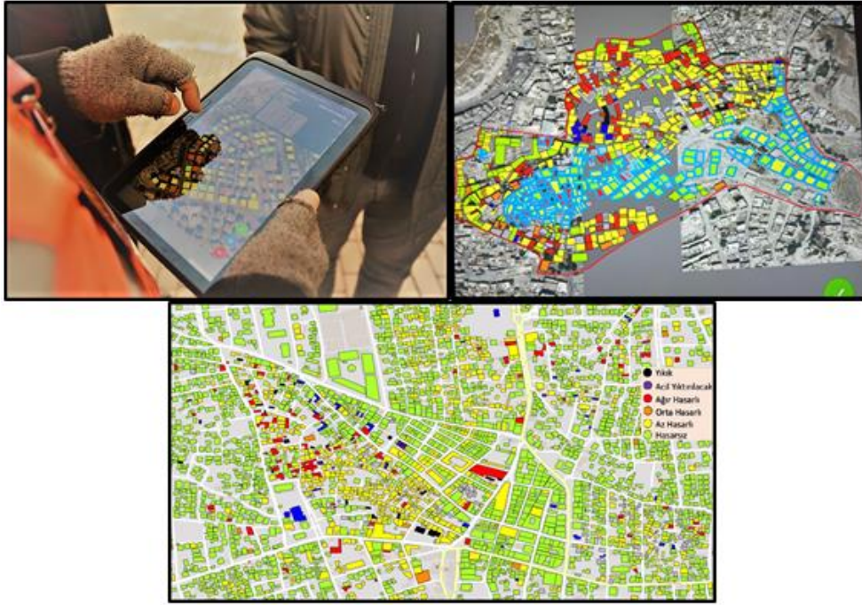
Şekil 4. Hasar tespiti saha çalışması
