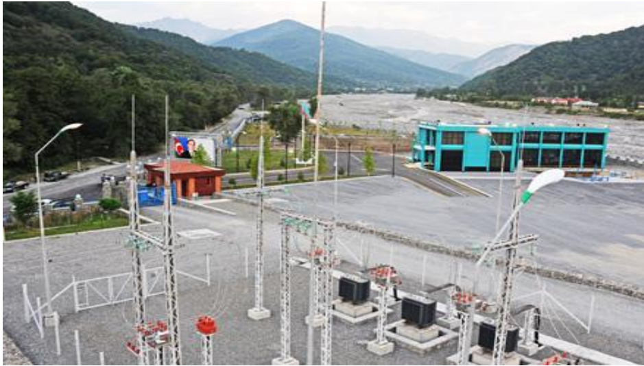
Şəkil 6. KSES binasının ümumi görünüşü
